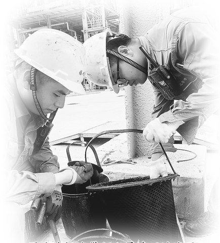
图为连振海带领人员清理过滤器
