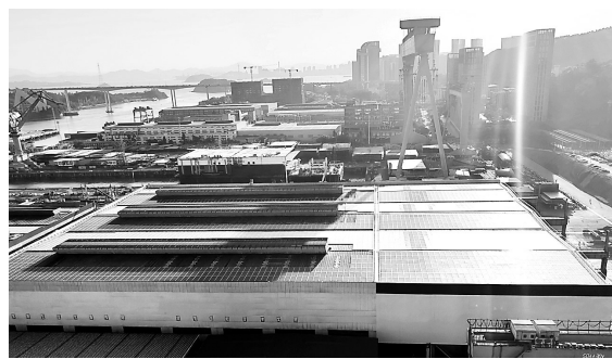
12月17日,福能海峡公司投资建设的厦船重工5.996MW分布式光伏发电项目成功并网发电。(陈诚昊 陈仕泓 摄)
